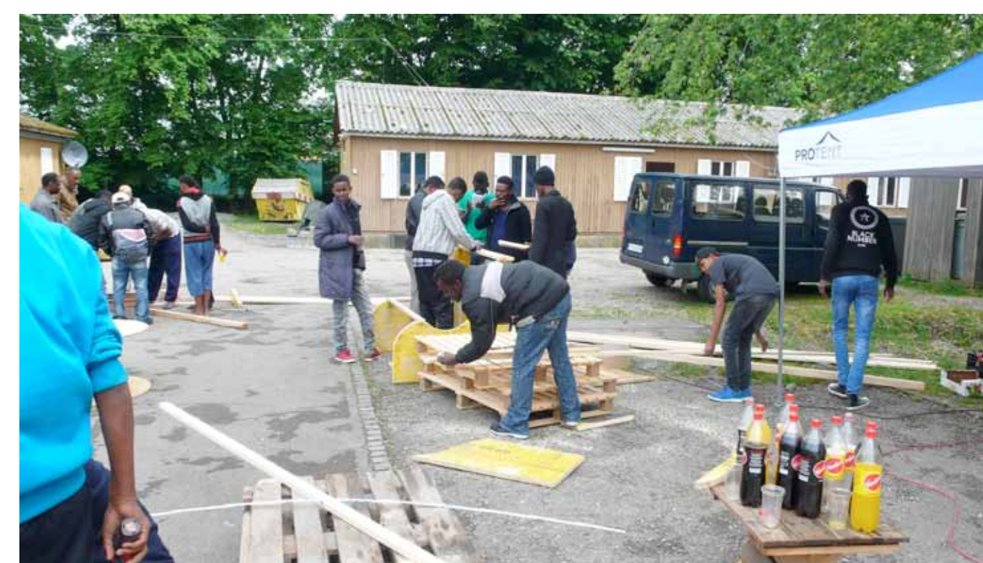
Der Bauplatz am Auffahrtswochenende
